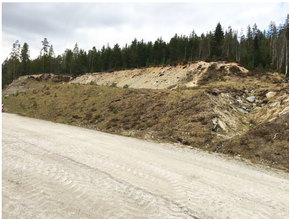
Bildet er tatt fra Østfjellveien, sør for den elektroniske bommen, mot øst. Driftsflata ligger på ca. kote 623, mens topp uttak ligger på ca. kote 637. Den etablerte vollen mellom vegen og uttaket, bidrar lite til skjerming av uttaksområdet.
